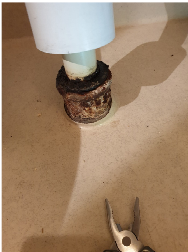
Rostigt tvättstalls avlopp i våtrum
