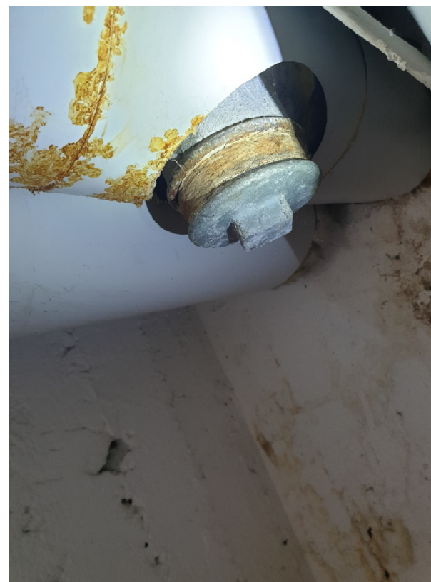
Läckande vattenledning i rörstråk i krypgrund
